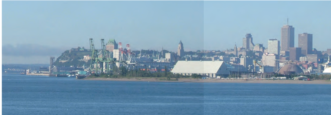
X01. BAIE DE BEAUPORT
