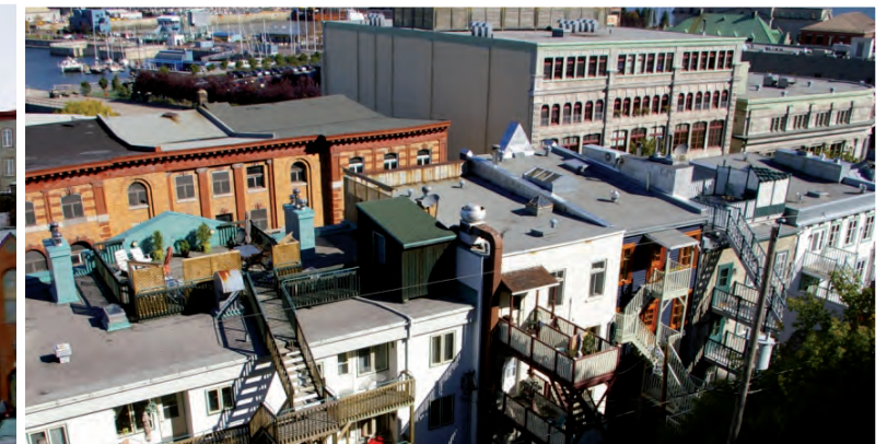
PHOTO 6. LES INSTALLATIONS EN TOITURE DOIVENT S'INTÉGRER À L'ARCHITECTURE
