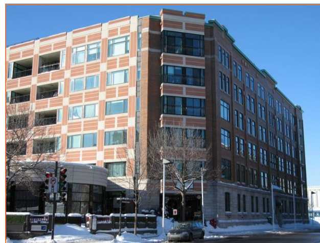
Un exemple d'un projet d'habitation réalisé sur la rue Dalhousie, dans le secteur de la Basse-Ville.
