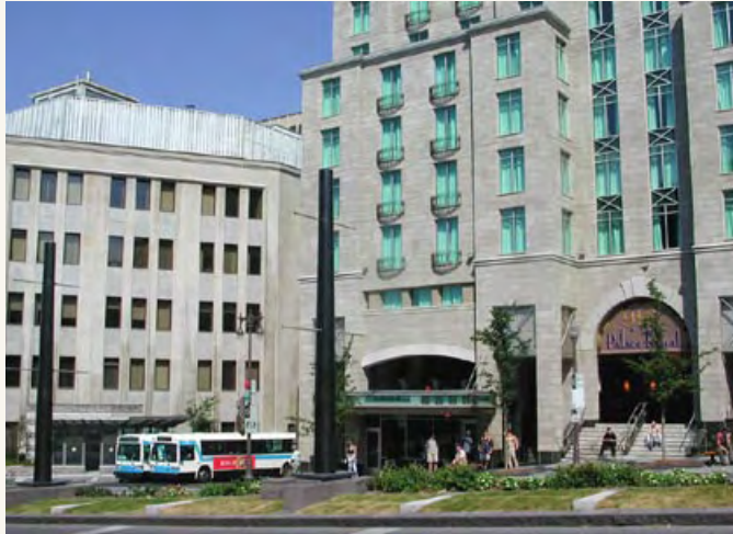
Abribus intégré à l'architecture: avenue Honoré-Mercier
