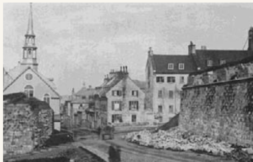
Percement des murs de fortification de Québec en vue de la construction de la porte Kent (1878)
