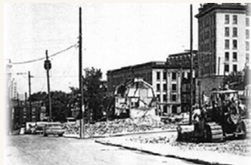
Démolition des bâtiments de la rue de l'Artilerie (1962)
