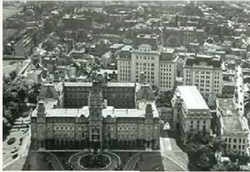
Édifices B,C,D et E au sein du faubourg St-Louis (1970)
