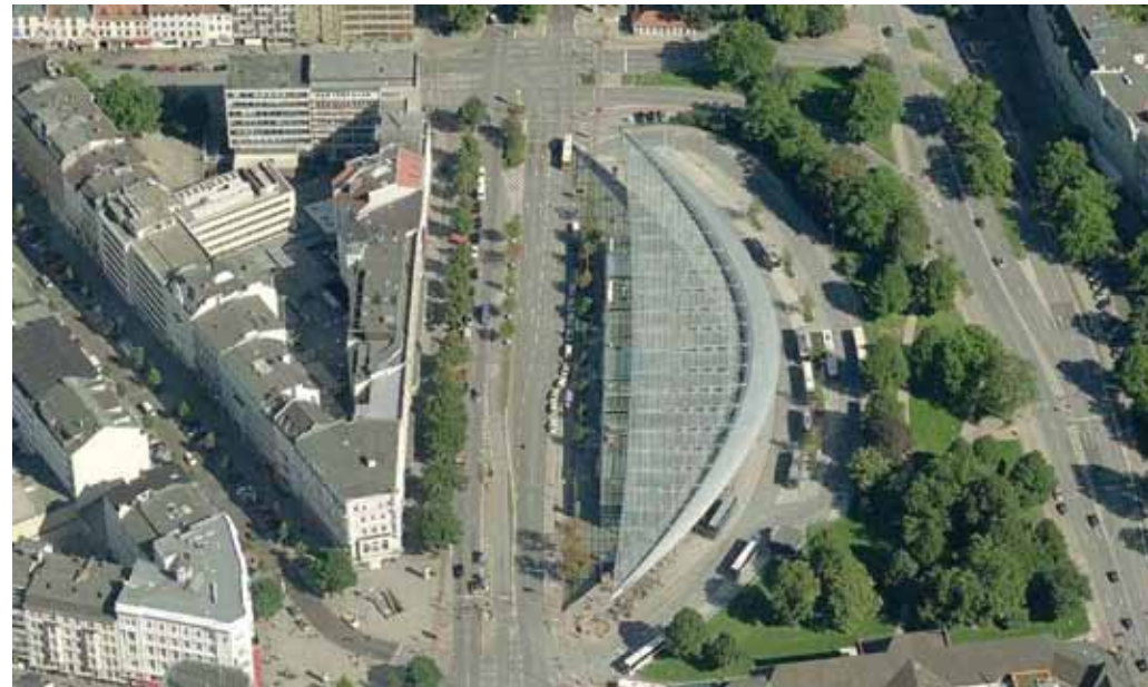
Un pôle d'échange à Hambourg.
